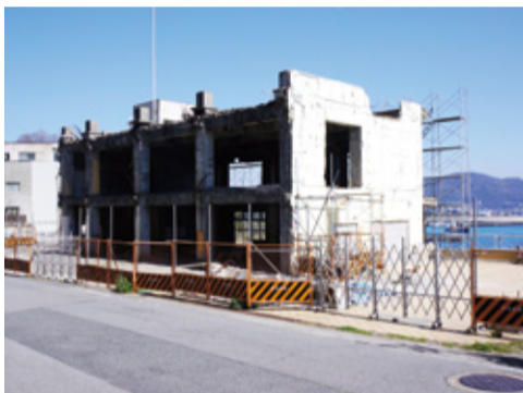
▲解体中のほうらい荘
