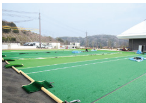
▲建設中のつつじヶ丘テニスコート
