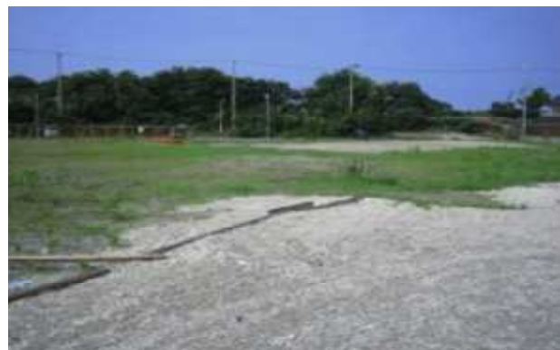
旧労災病院跡地。現在は民間分譲地造成中
