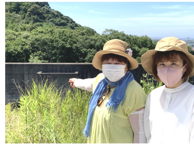
坂ノ谷の既設2号調整池にて
