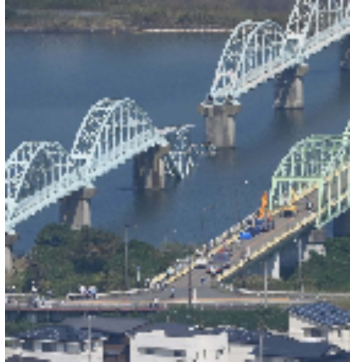
崩落した六十谷水管橋と仮設水道管を設置した六十谷橋（工事時の毎日新聞写真より）
