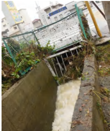
7月豪雨の有功地区の水路 (水があふれ浸水被害が発生)
