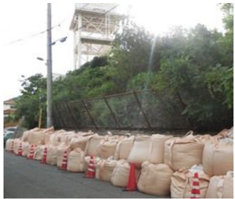
7月6日からの大雨による園部地区の土砂災害の様子
