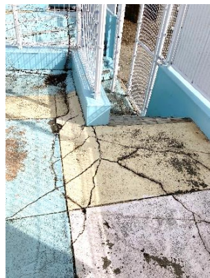
ひび割れたプールサイドの床
