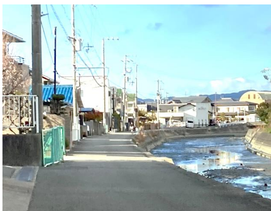
ガードレールが無く転落しそうな道路
