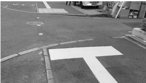
補修された点字ブロック
