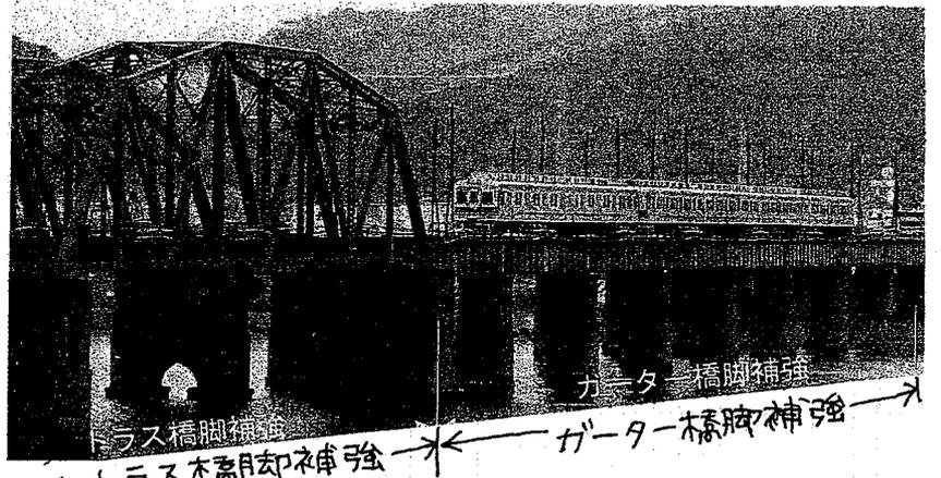
トラス橋脚補強 ← ガーター橋脚補強 →
