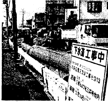
下水管理設後埋め立てした水路
